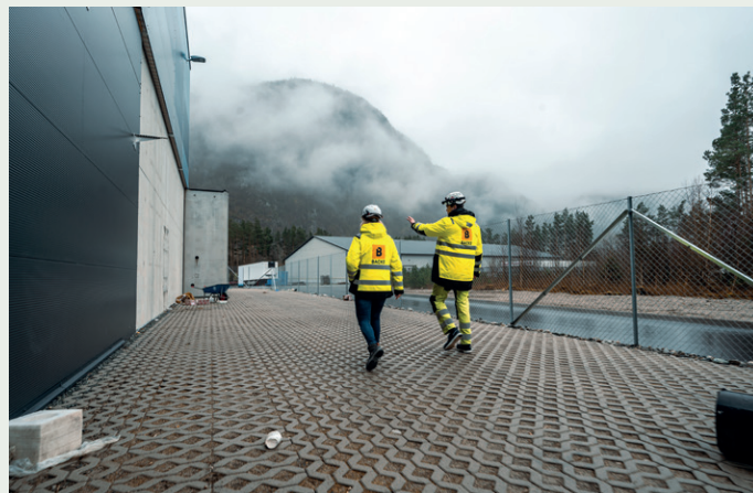
Det permeable dekket langs hallene leder nedbør til grunnen, og er en effektiv måte å håndtere nedbør på i regnfylte Ryfylke.
