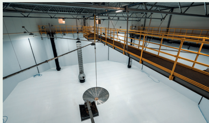
Det er fire kar i hver hall, hver av disse er 6,3 meter høye, og med 21 meter innvendig bredde.
